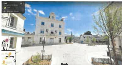
Exemple : aménagement des abords de la mairie de Vouvray - 37
